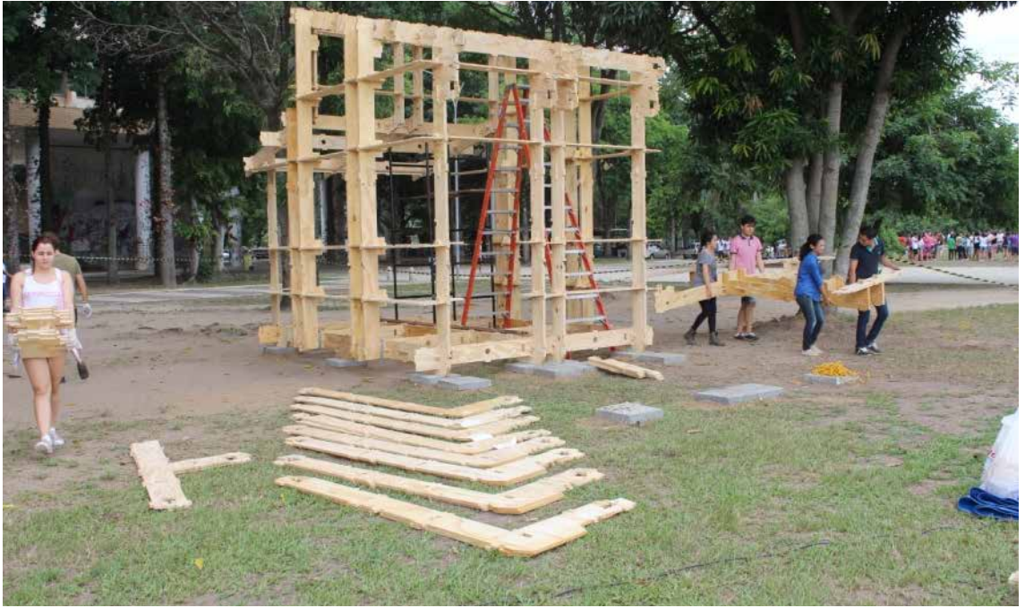
Figura 14: Estrutura de fechamento final pré-montada para encaixe no pórtico. Acervo dos autores.
